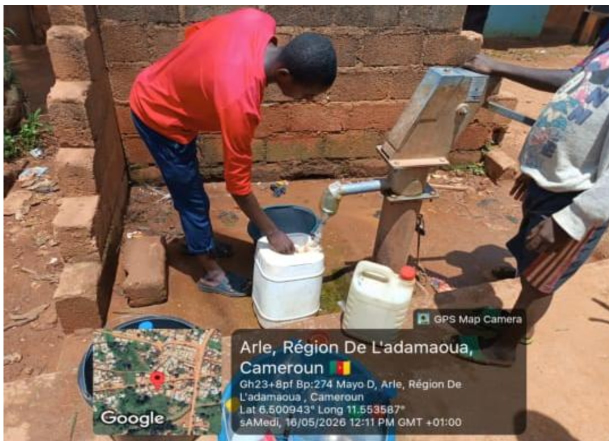
Photo 9 : Ancien point d'eau potable, récemment réhabilité/dépanné par Zenith Mining et fonctionnel dans le village Fada
