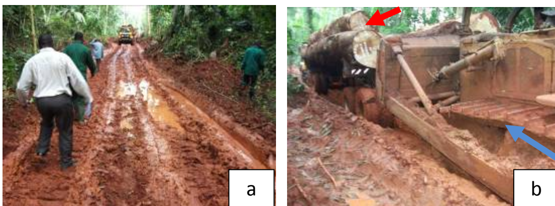
Fig. 17. Route d'accès à un parc à bois de la VC 10 03 189. (a) : l'équipe de mission et le responsable du chantier progressant vers le parc à bois ; (b) : un grumier (flèche rouge) poussé par un engin à chaînes (flèche bleu).
