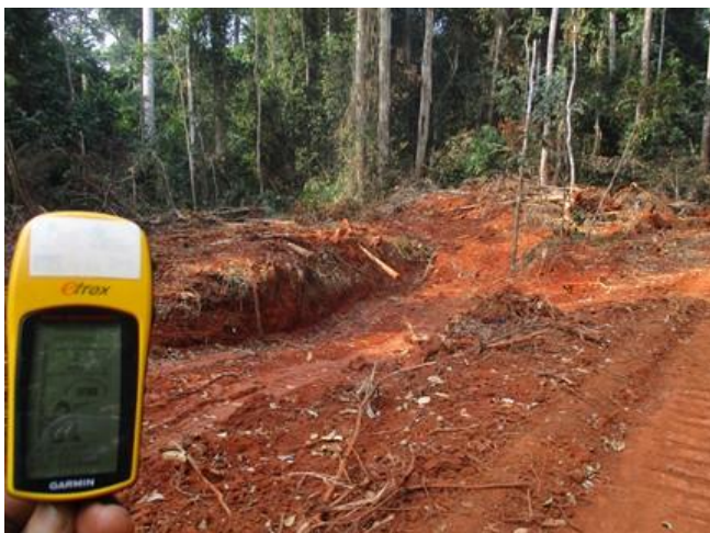
Photo 5.1.2a) : Parc non marqué vidé de son contenu avec Quai de chargement ; GPS 33N X : 272 814 ; Y : 406 354
