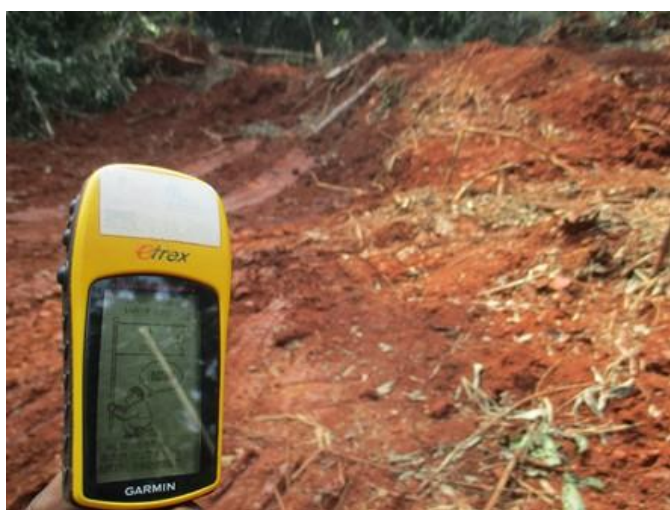
Photo 5.2.6a) : Quai de chargement de grumes GPS 33N X : 274 094 ; Y : 402 209
