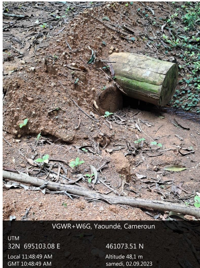
Photo 8 : Cours d'eau non dénommé obstrué à la suite de la construction d'un pont forestier dans la VC 0703405
