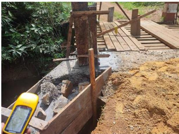
**Photo 11 :** Pont détruit par les grumiers et en cours de reconstruction dans le village Bifa'a
