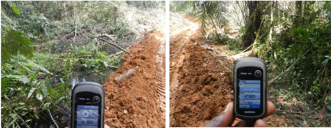
**Photo 14** : Obstruction d'un cours d'eau non dénommé due à la mauvaise réalisation du pont forestier ayant pour coordonnées X : 724743 ; Y : 343433
